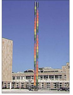
Stahlblechs erreicht. Die Emaillierung sichert den dauerhaften Korrosionsschutz.
